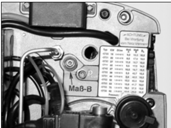
Abb. 12: Einstellung Maß B und Messnippel Gebläsepression
