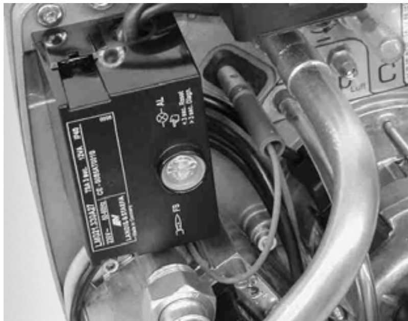
Abb. 22: Ionisationskabel mit Stecker
