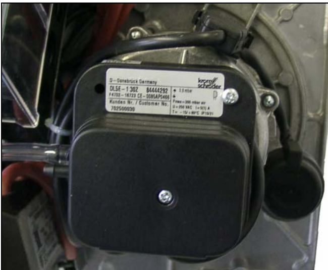
Abb. 8: Luftdruckwächter
