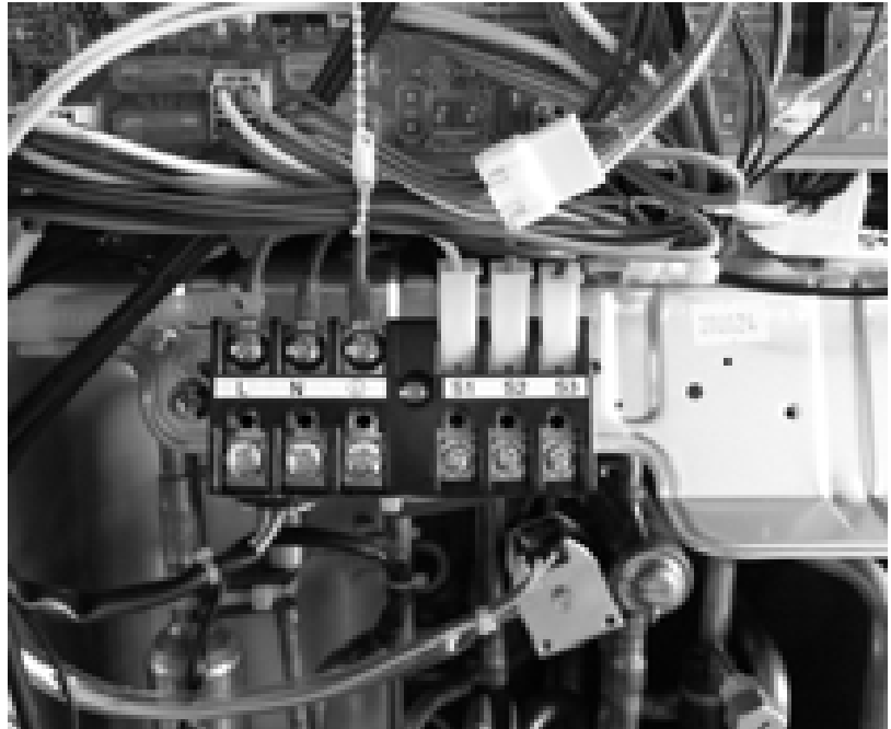
Abb. 38: Klemmleiste 230 V Außeneinheit ThermiAir 10
