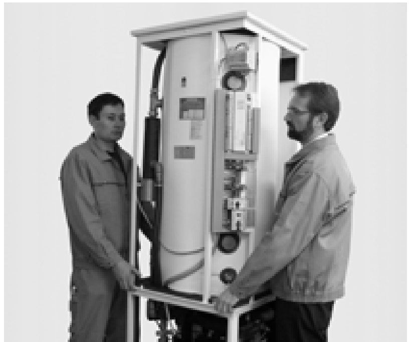
Abb. 21: Speicher am äußersten Rand anfassen, hoch heben und zur Seite stellen.
