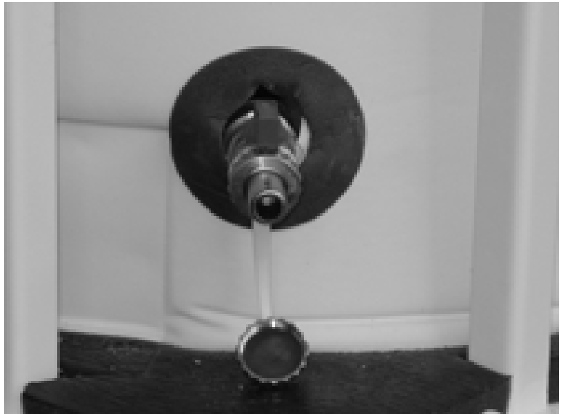
Abb. 28: Füll- und Entleerhahn Speicher
