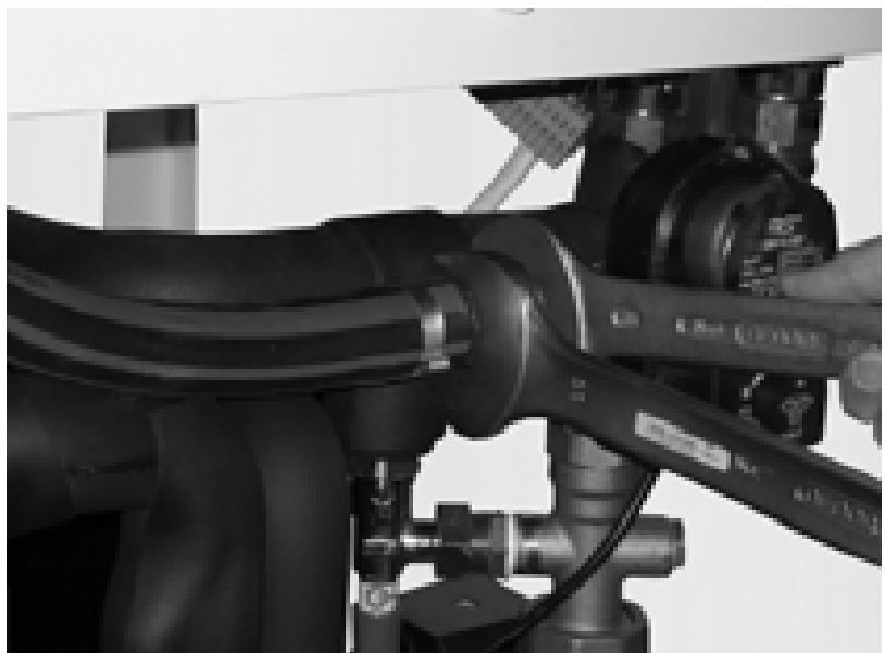
Abb. 19: Überwurfmutter des Schlauches lösen und abschrauben.
