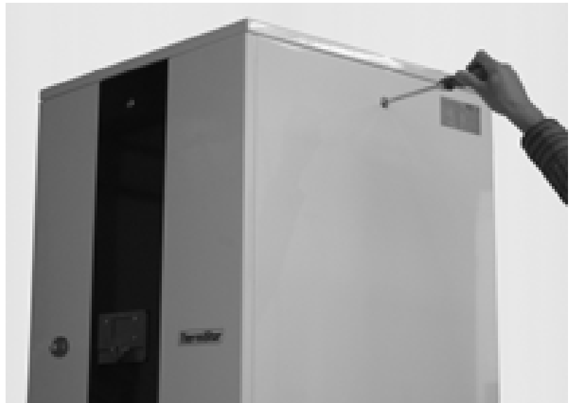
Abb. 33: Schnellverschluss-Schraube der rechten oberen Verkleidung zur Demontage lösen (90°)
