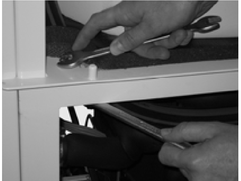
Abb. 20: Die vier Verschraubungen unter der Isolierung am Bodenteil des Speichers lösen und herausnehmen.
