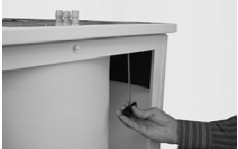
Abb. 35: Die vier Inbus-Schrauben heraus-schrauben.
