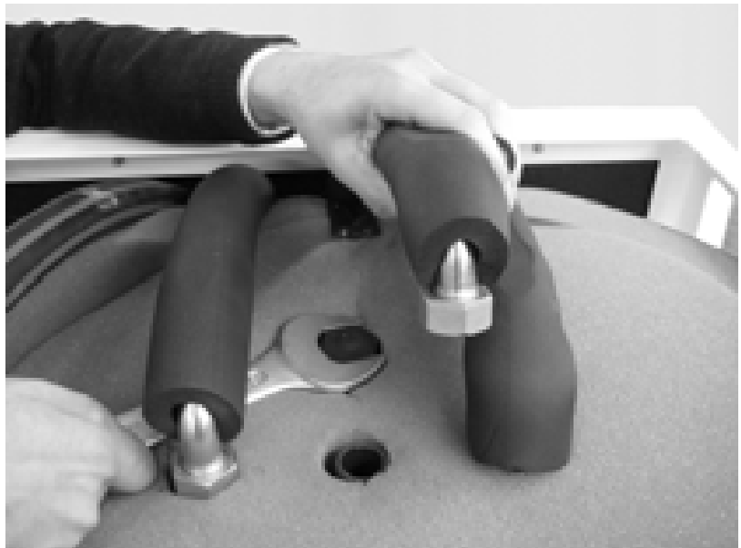
Abb. 36: Magnesium-Schutzanode heraus-schrauben und prüfen.
