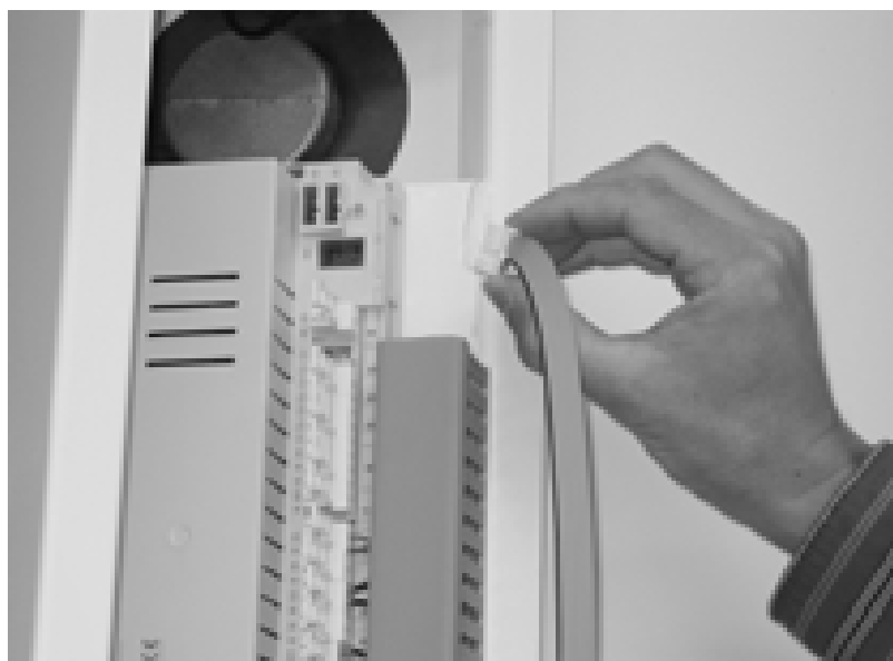
Abb. 11: Anschluss-Stecker des Bediengeräts vom Regler abziehen.
