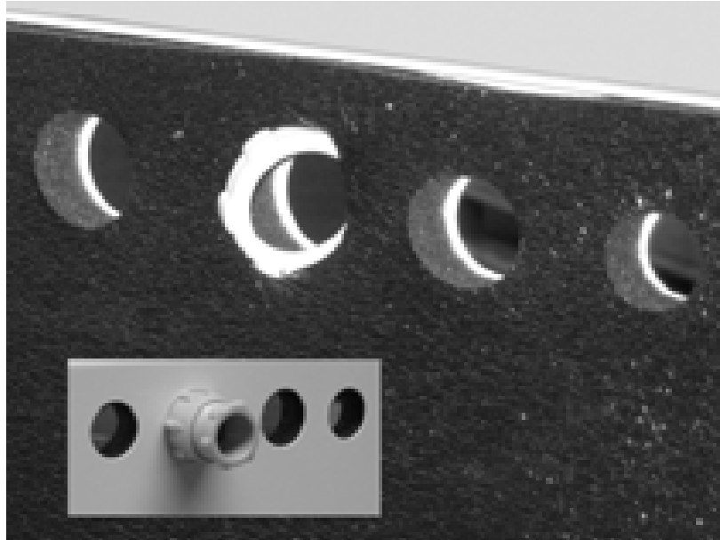
Abb. 15: Gegenmutter in Isolierung einsetzen und Kabeldurchführung einschrauben.
