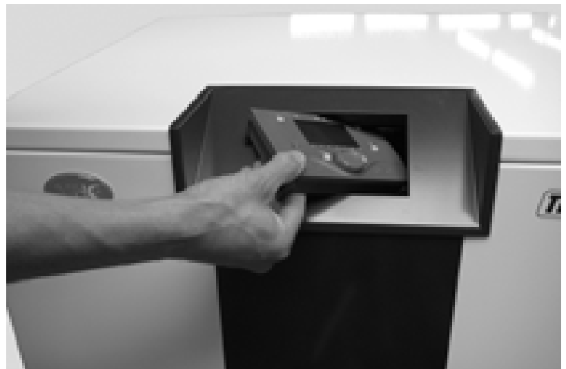
Abb. 39: Bedieneinheit durch die Öffnung der Halterung stecken und Innen ablegen.
