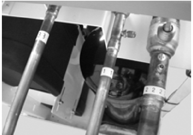
Abb. 16: Anschlüsse Wärmepumpe
