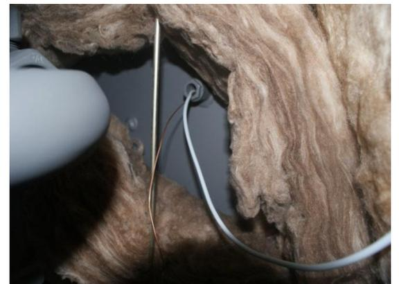
➤ Unterdruckrohr auf Blech befestigen und mit Unterdruckrohr aus dem Kessel kommend mittels Silikonschlauch verbinden
