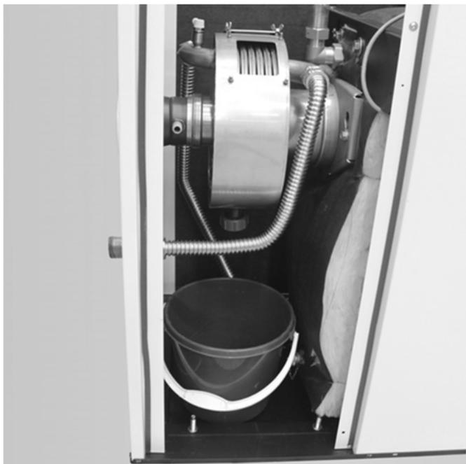
Abb. 59: Zur Reinigung vorbereiteter RWT
