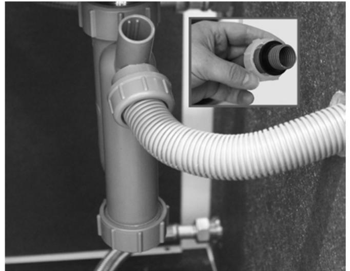
Abb. 7: Montage des Kondensatschlauchs
