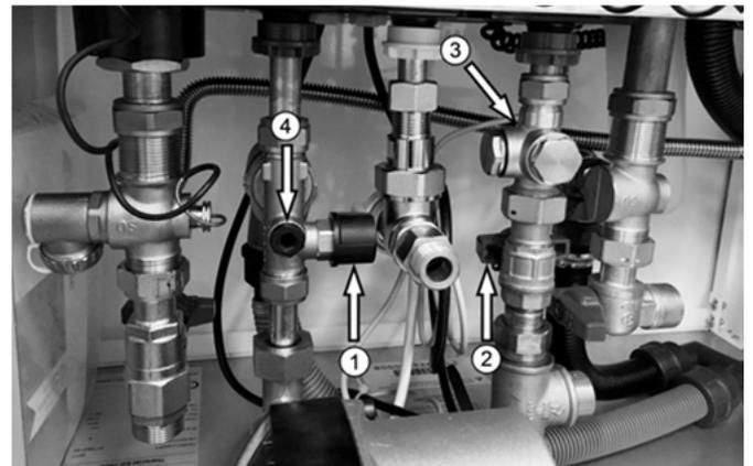
Abb. 81: Spülanschlüsse der Trinkwarmwasserschlange beim Kompakt
