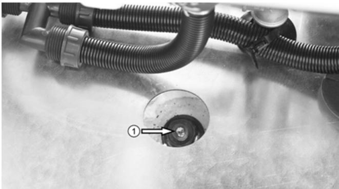
Abb. 79: Position der Magnesium-Schutzanode ①
