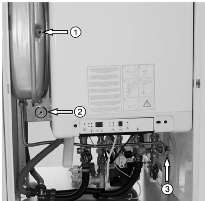
Abb. 55: Drei wichtige Stellen bei der Befüllung der Anlage (Kompakt)
