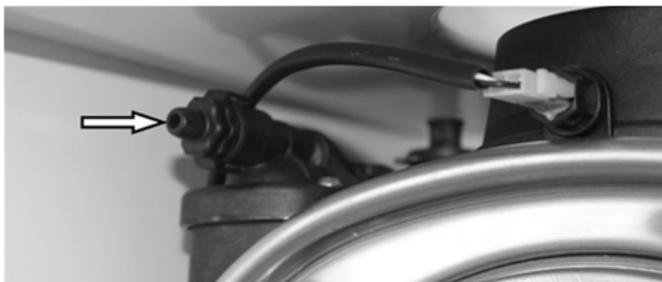
Abb. 29: Kesselkörper-Entlüfter
