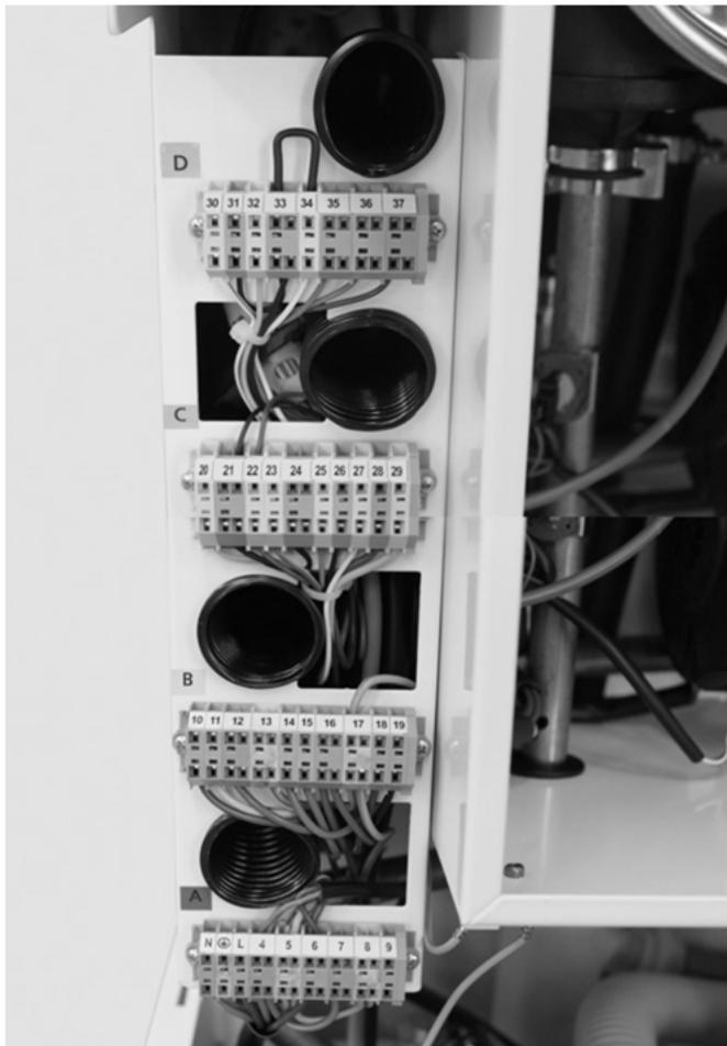
Abb. 18: Elektrische Anschlussklemmen ProCon E...
