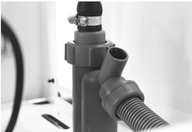
Abb. 11: Siphon und Kondensatschlauch
